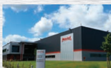
Nouveau site industriel de Gisors (France)
